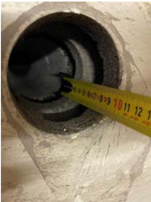
Kuva 10: Autosuojan betoniseinän porareikäkoe, harkko 100 mm.
