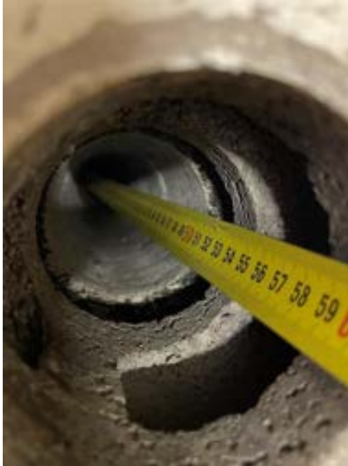
Kuva 9: Autosuojan betoniseinän porareikäkoe, seinä 500 mm.
