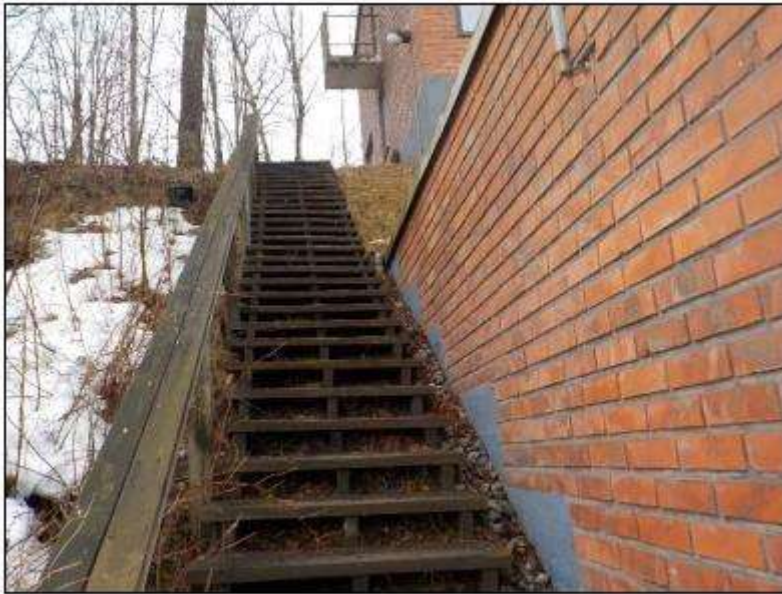
Kuva 3: Autosuojan ulkoseinä on tiiliverhoitu (Kuntotarkastus 7.4.2021).
