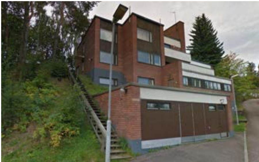
Kuva 2: Olemassa oleva rakennus, näkymä kadulta, etualalla autosuoja. Uudisrakennus sijoittuu olemassa olevan rakennuksen vasemmalle puolelle.
